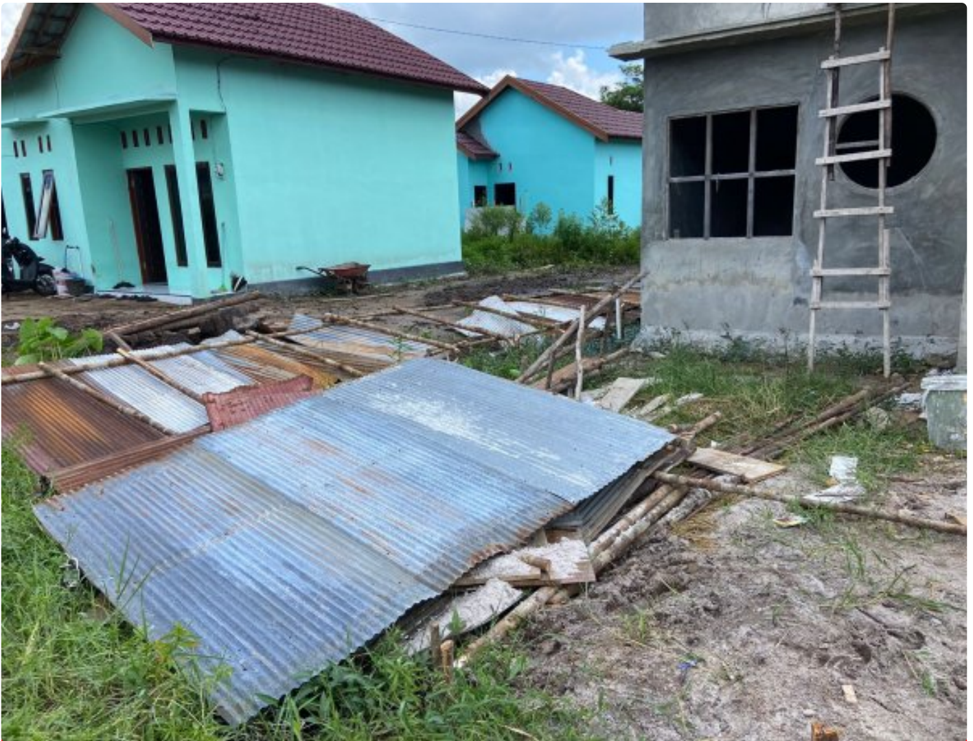
Gambar: Kondisi Pagar Seng Yang Dirusak Oknum
